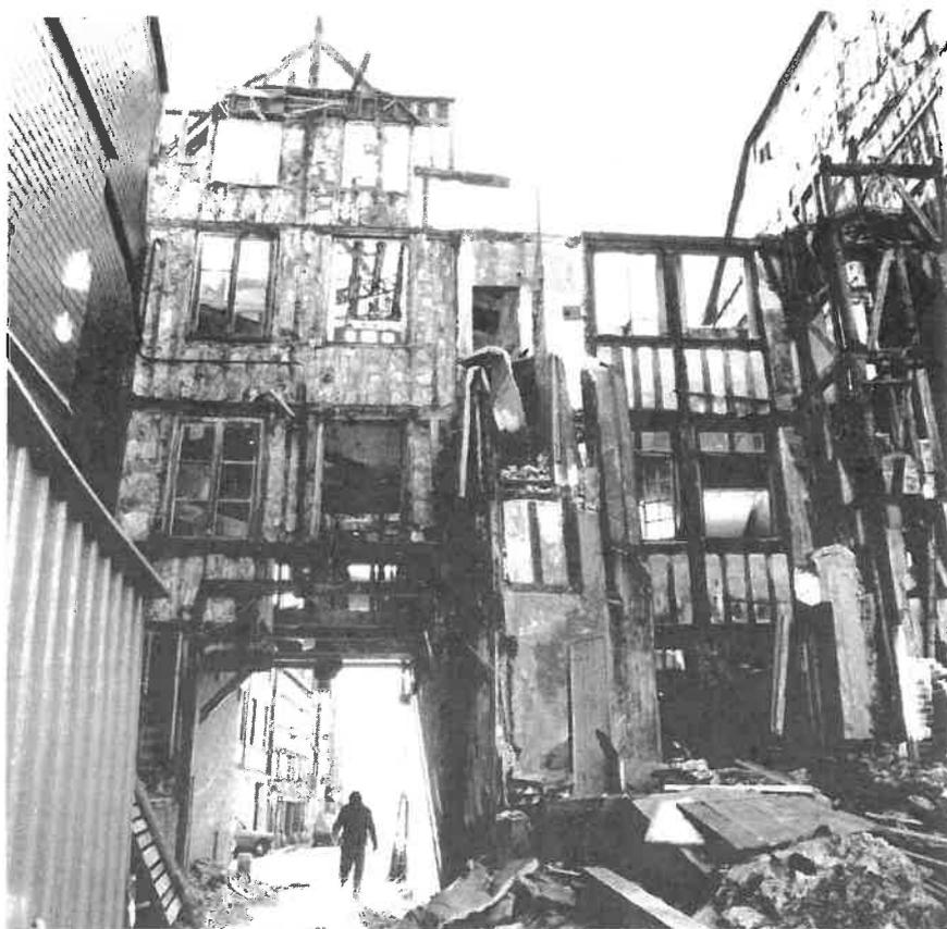
**PHOTO 13 :** Façade sur cour. La maison du Luthier côté nord offre un excellent exemple d'architecture en pan de bois. Alors que la façade sur rue présente les caractéristiques nouvelles d'un style neuf, la partie sur cour s'en tient à une décoration plus traditionnelle : les impostes des fenêtres se dessinent encore dans les pièces horizontales. L'audace des moulures en baguettes n'a pas été reprise dans cette partie moins visible.
