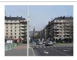
Les deux immeubles, symétriques, présentent une ossature verticale apparente, un remplissage en pierre, des balcons aux angles, un auvent en béton protégeant les rez de chaussée occupés par les commerces. 6 niveaux, avec une corniche au 5ème étage portant un balcon filant sur l'ensemble de l'îlot. Toitures en ardoises.
