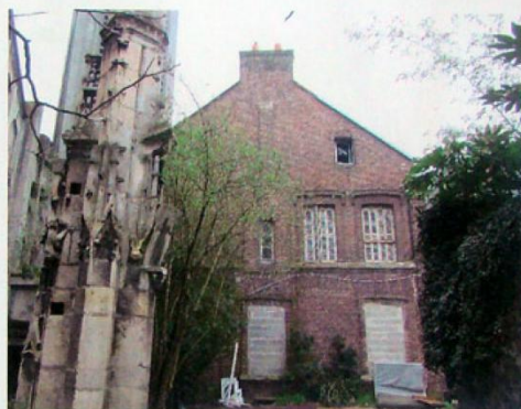
Presbytere côté rue des Requis
