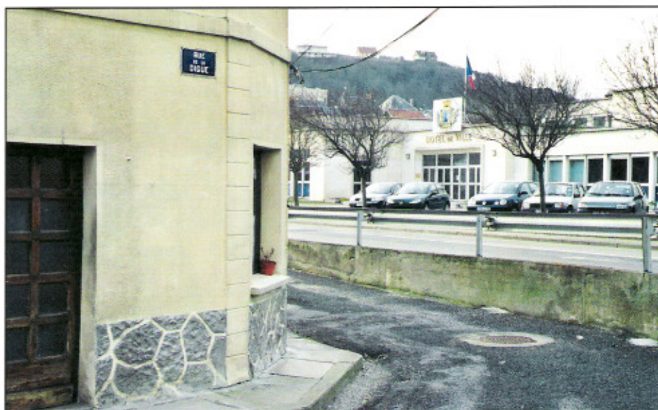
Différence de niveau entre la nouvelle et l'ancienne route
