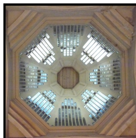
Coupole de la nef, béton translucide
