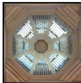
Coupole de la nef, béton translucide
